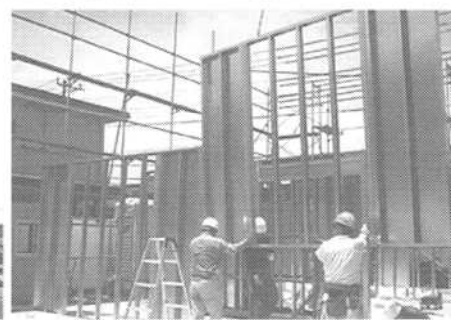
スチールパネル工法は現場での作業も楽に出来て、大幅な工期・コスト短縮が可能。
